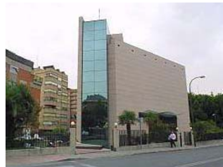
Prédio TransTOOLS no Paseo da Habana, em Madrid, sede do escritório central da empresa na Espanha.
